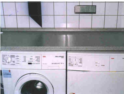
Waschmaschinen- und Trocknersteuerung
